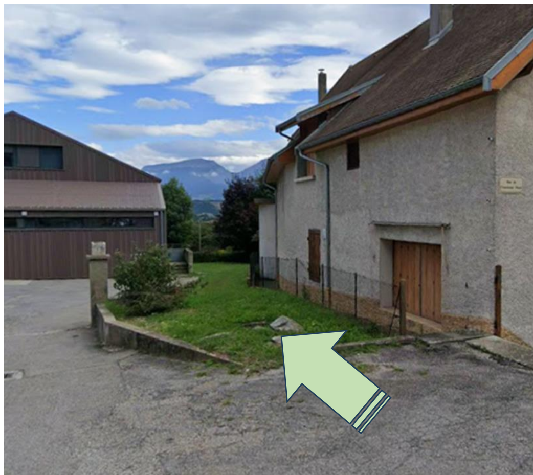
Photo n°1 : ruisseau de Lalley busé au niveau de la parcelle AB-148 – salle des fêtes
